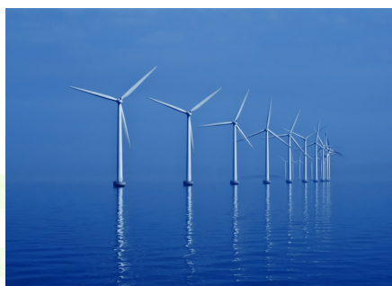
Parque eólico off-shore.
