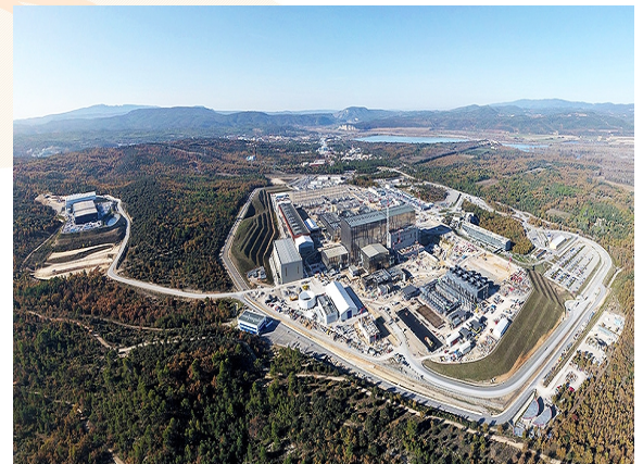
Vista aérea del sitio del proyecto. (Gentileza ITER)
