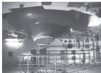
Central Nuclear Atucha II Vista inferior del generador de vapor
