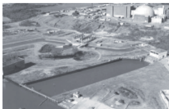
Central Nuclear Atucha II Toma de agua
