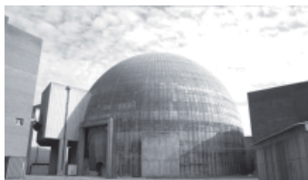
Central Nuclear Atucha II (en construcción) Recinto de contención
