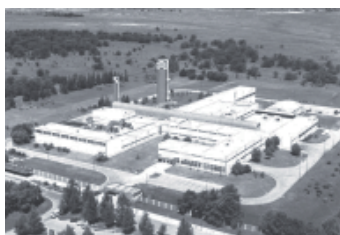
Combustibles Nucleares Argentinos S.A. (CONUAR S.A.) – Ezeiza
