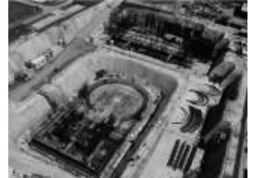
Central nuclear argentina CAREM Cimientos del edificio del reactor
