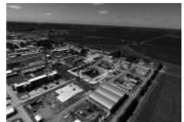
Proyecto Central Nuclear argentina CAREM - Vista general de las obras Lima - Pcia. de Buenos Aires
