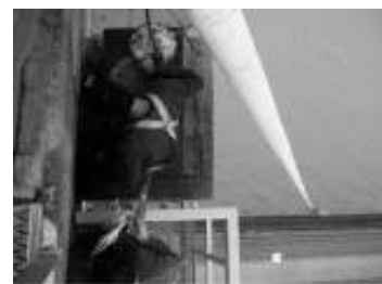
Ensayos No Destructivos Inspección de obenque de puente con ultrasonido
