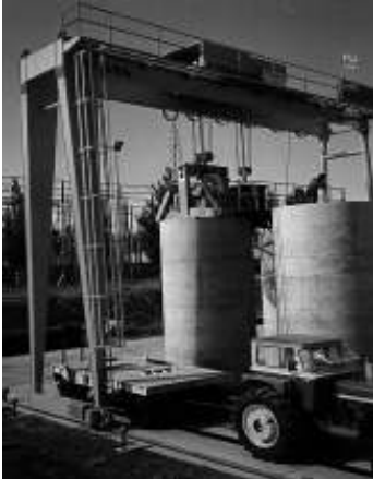
Carga de silos para almacenamiento temporario en seco de combustibles gastados Central Nuclear Embalse
