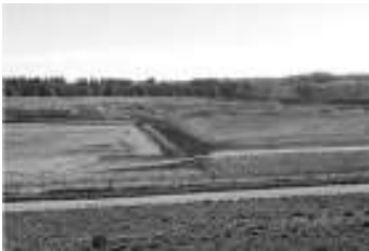
Proyecto Restitución Ambiental de la Minería del Uranio (PRAMU) Trabajos de restitución Ex - Complejo Minero Fabril Malargüe Pcia. de Mendoza
