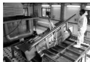
Trabajos de montaje del reactor de Investigación OPAL construido en Australia por INVAP S.E.
