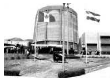
Edificio del reactor de investigación RP-0 construido por la CNEA en el Centro Nuclear de Investigaciones del Perú
