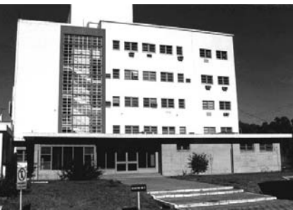
Edificio del Reactor RA-3
