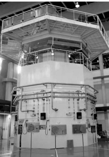
Reactor de Investigación RA-6 Centro Atómico Bariloche
