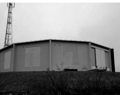
Proyecto Pierre Auger Edificio para telescopios en Cerro Los Leones
