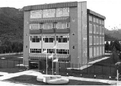
Edificio del Reactor RA-6
