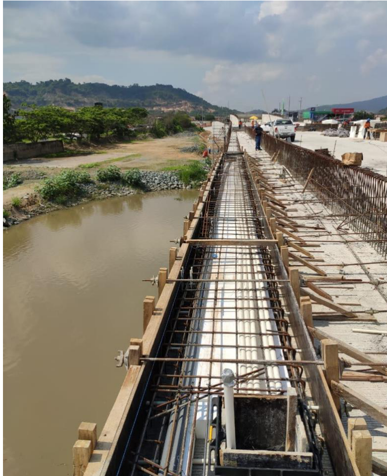
Figura 1. Proceso de encofrado de losa de hormigón armado en puente Guayaquil-Daule. Fuente: Autor.
