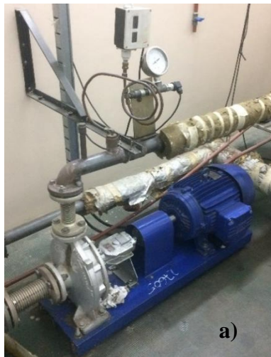
Figura 2.3. a) Vista de la bomba impulsadora de aceite. b) Curva característica provista por el fabricante.
