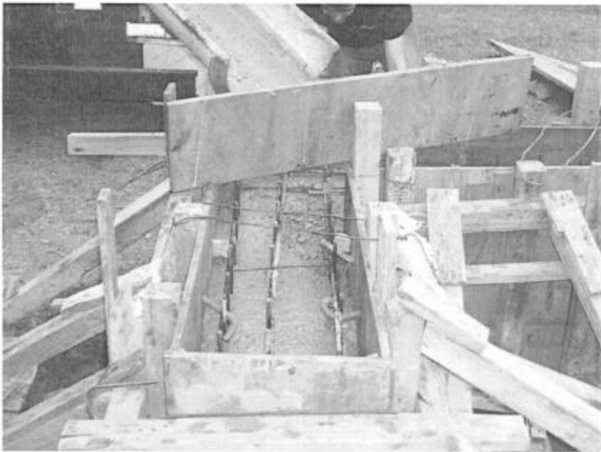
Figura 3.11. Proceso de colado del hormigón.
