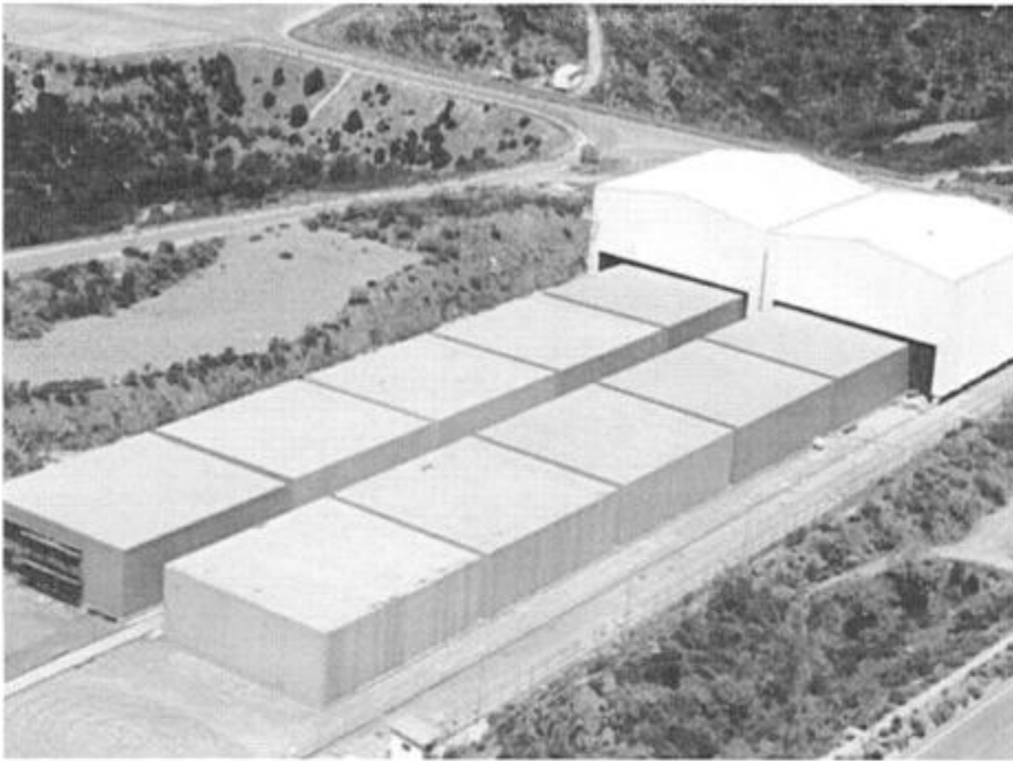
Figura 1.2. Celdas de hormigón armado del repositorio de residuos radiactivos de El Cabril (España).
