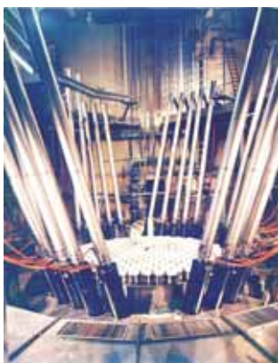
Central Nuclear Atucha I - Núcleo del reactor
