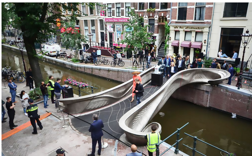
Fig. 2 – Primer puente de metal construido por impresión 3D del mundo. Fue fabricado en acero inoxidable, por medio del proceso WAAM. (Ámsterdam – Países Bajos) (Crédito: Adriaan de Groot / 3DMX Inc. 4)
