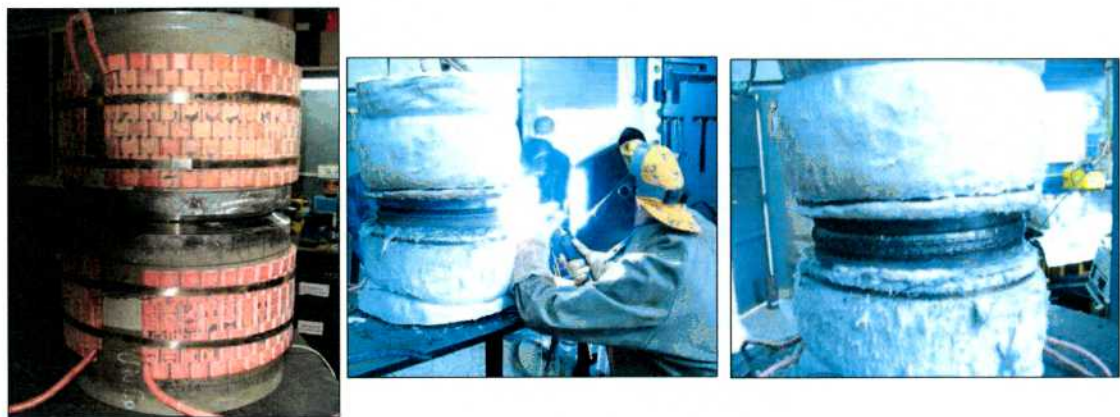
Figura 1.4. Secuencia de realización de las soldaduras.
