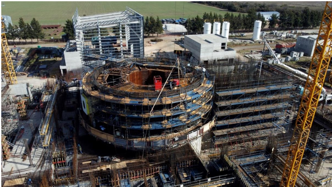
Imagen n° 1. Central nuclear CAREM en construcción. Obtenida en: https://www.argentina.gob.ar/cnea/carem/la-construccion-del-carem-en-fotos
