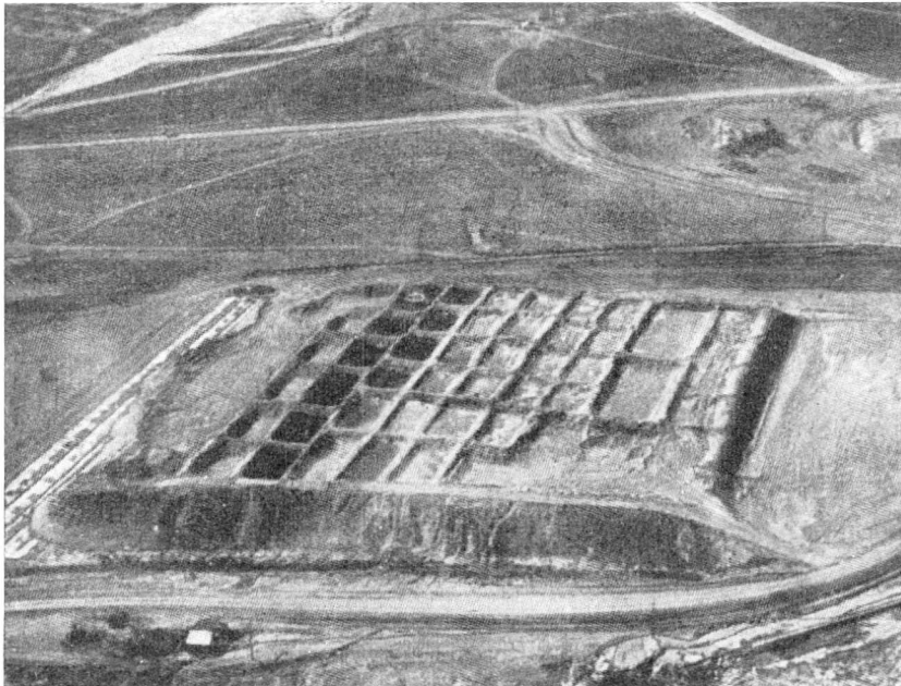
Fig. 3. — « Heap leaching » de 280.000 t de mineral de uranio de baja ley (0.05-0.07 % U_3O_8 ) en la mina Lucky Me, de Wyoming (E. U. A.)
