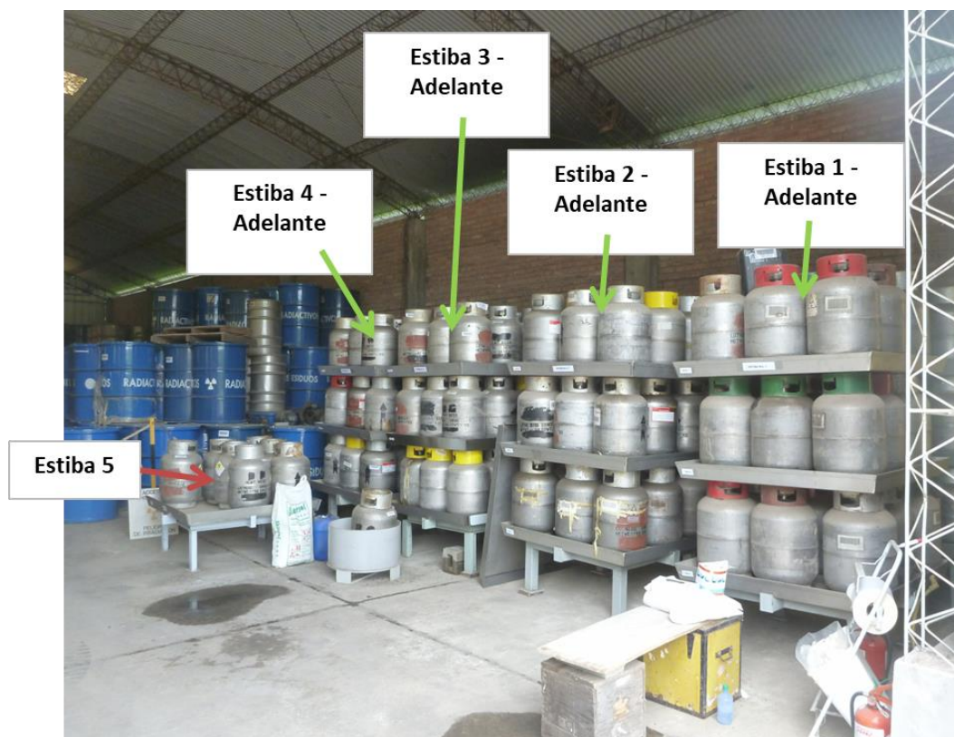
Figura 12: Fotografía del depósito de almacenamiento de garrafas
