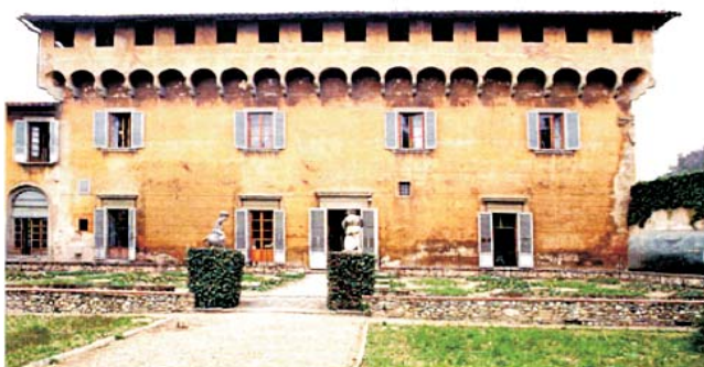
Montaje termográfico del frente de un edificio
