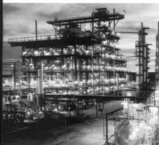
Planta Industrial de Agua Pesada. ENSI S.E.
