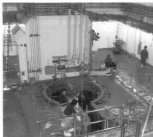
ETRR-2 Reactor Nuclear de Investigación. Centro de Investigación Nuclear de Inshas. El Cairo-Egipto. Sala del Reactor durante el Montaje.
