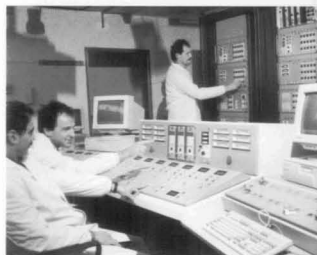
Sala de control del Reactor.
