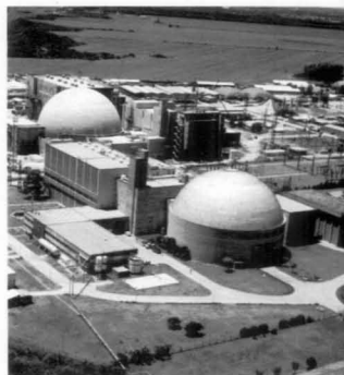
Vista aérea de la Central Nuclear Atucha I. Detrás, la Central Nuclear Atucha II, en construcción.
