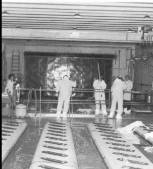
Vista general de las piletas de almacenamiento temporario de los elementos combustibles gastados. Centro Atómico Ezeiza.
