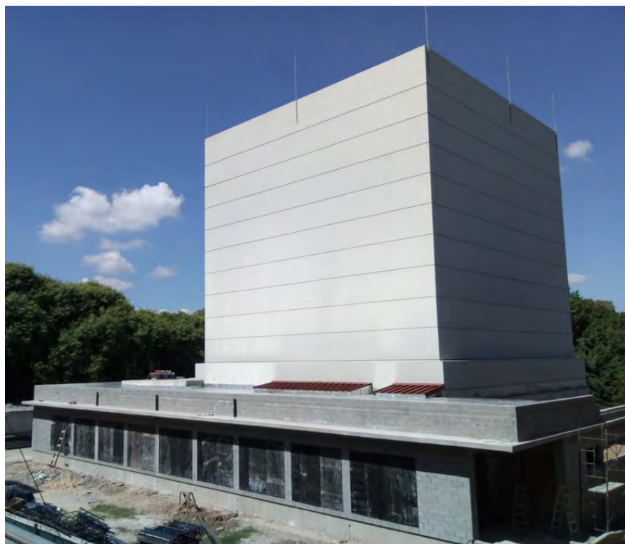
Figura 1.2: Estado actual del edificio para BNCT que se está construyendo en el CAC, CNEA.
