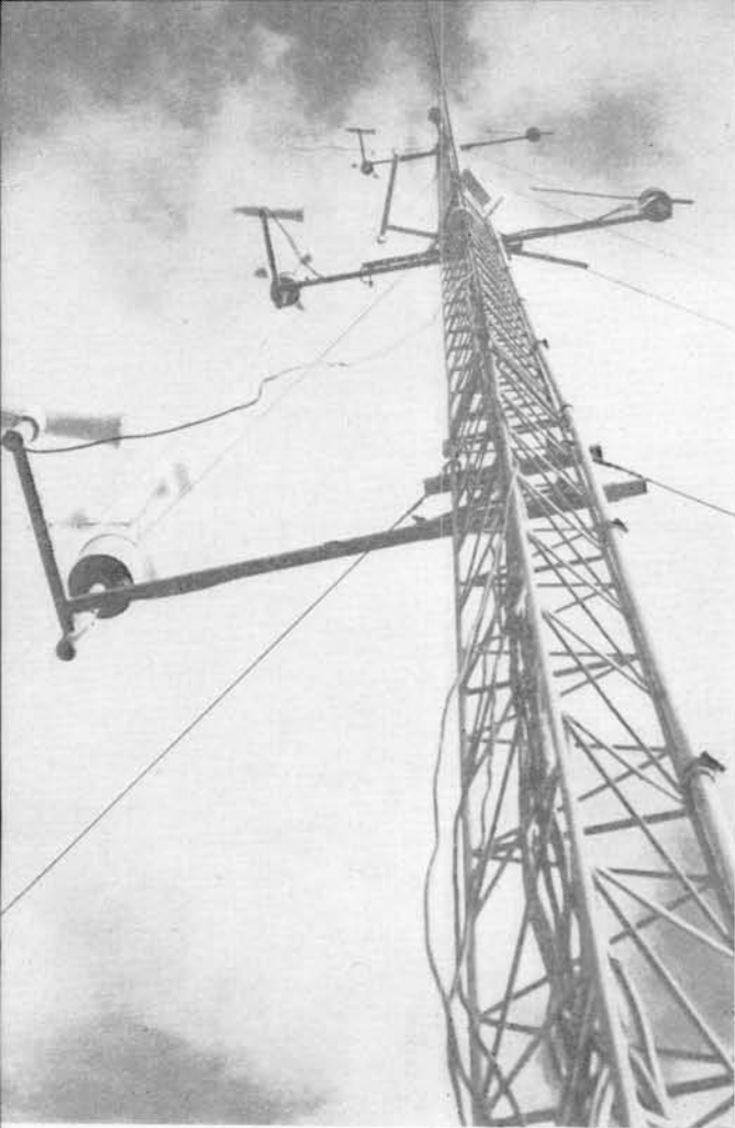
Torre micrometeorológica instalada en el Centro Atómico Ezeiza.
