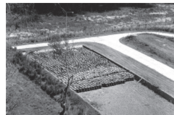
Área temática Seguridad nuclear y ambiente Trinchera para almacenamiento temporario de residuos de baja actividad Área de Gestión Ezeiza
