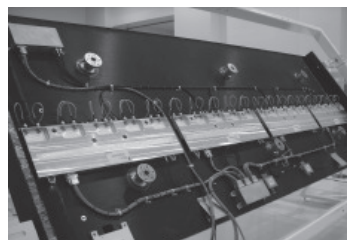
Proyecto ARAS - Finalización de la integración del cableado al modelo de calificación estructural de panel X7 CE X7 CE para ensayo en Brasil.
