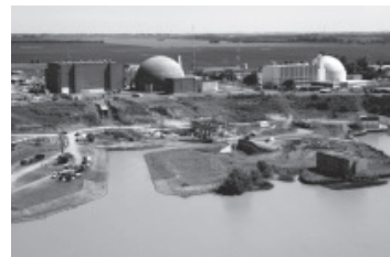
Área temática Reactores y centrales nucleares Centrales Nucleares Atucha I y II
