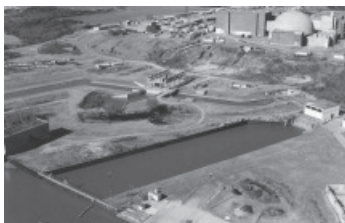
Proyecto Soporte tecnológico a la construcción y puesta en marcha de la Central Nuclear Atucha II Toma de agua
