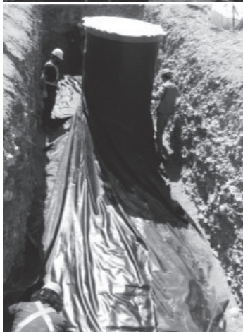
Proyecto Internacional Pierre Auger Instalación del segundo módulo detector de muones en Malargüe Arriba: instalación del módulo de 10 m 2 en el pozo de 2,25 metros de profundidad Abajo: tubo de servicio y geomembrana de cubrimiento
