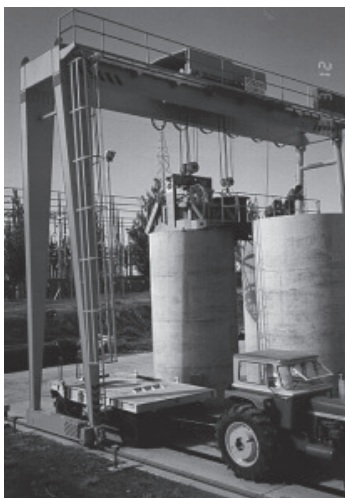
Carga de silos para almacenamiento temporal en seco de combustibles gastados - Central Nuclear Embalse
