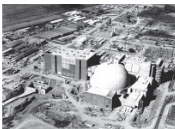
Proyecto Soporte tecnológico a la construcción y puesta en marcha de la Central Nuclear Atucha II y desarrollo de la ingeniería de sus elementos combustibles. Vista general de la obra
