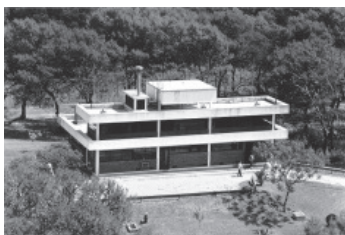
Gestión de residuos radiactivos - Edificio de acondicionamiento Área de Gestión Ezeiza Centro Atómico Ezeiza
