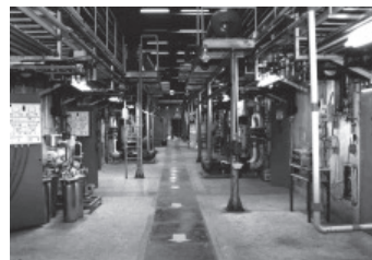
Proyecto enriquecimiento de uranio Interior de la Planta de Enriquecimiento por difusión gaseosa Complejo Tecnológico Pilcaniyeu
