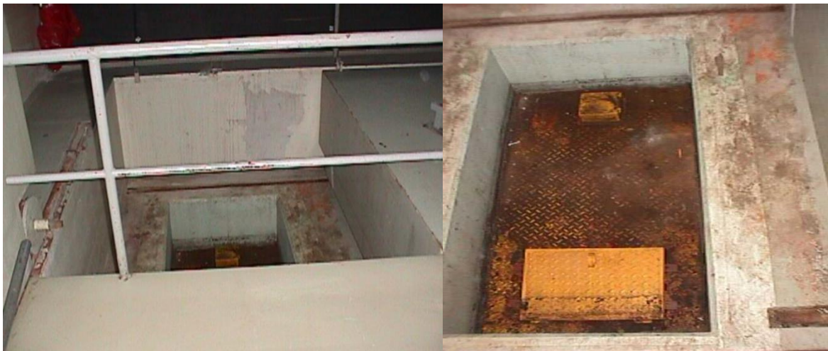
Figura 2. Recinto de almacenamiento de RII agotadas en la central nuclear Atucha 1, Argentina.
