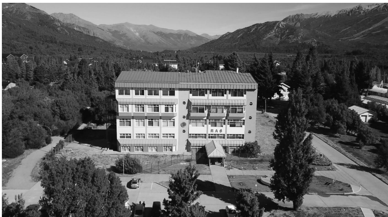
Edificio del Reactor de investigación RA-6. Centro Atómico Bariloche, Provincia de Río Negro.
