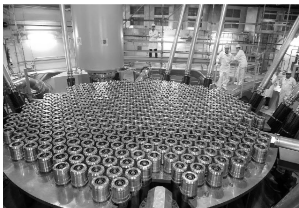
Reactor nuclear de potencia Atucha II. Lima, Provincia de Buenos Aires.
