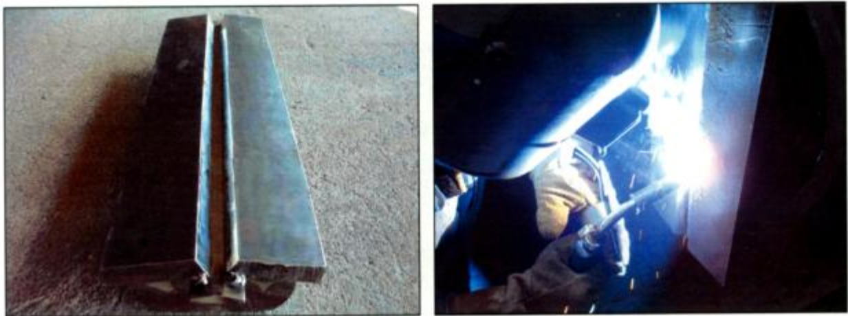
Figura 3.2. Armado y soldado de cupones.
