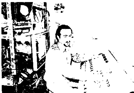
Figura 4: Gabinete de control y comando. Se pueden apreciar la consola de comando eléctrico y algunos equipos de medición.
