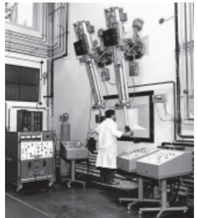
Planta de Producción de Fuentes Selladas de Cobalto 60 operada por DIOXITEK S.A.- Centro Atómico Ezeiza
