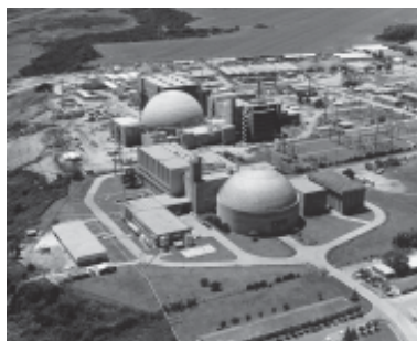
Central Nuclear Atucha II (en construcción) Pcia. de Buenos Aires
