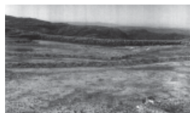
Proyecto Restitución Ambiental de la Minería del Uranio (PRAMU): ex Complejo Minero Fabril Los Gigantes Diques de contención
