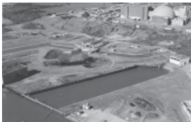
Central Nuclear Atucha II (en construcción) Toma de agua
