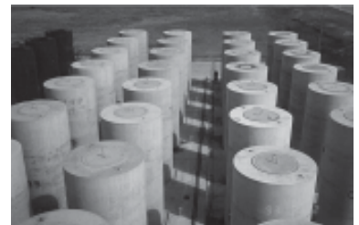
Almacenamiento temporario en silos de elementos combustibles gastados Central Nuclear Embalse - Pcia. de Córdoba
