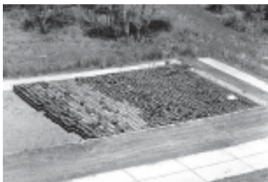
Área Seguridad Nuclear y Ambiente: Trinchera para almacenamiento temporario de residuos de baja actividad Área de Gestión Ezeiza Pcia. de Buenos Aires
