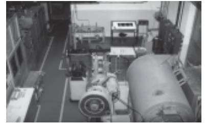
Área Aplicaciones de la Tecnología Nuclear: Fabrica de elementos combustibles para reactores de investigación Centro Atómico Constituyentes Pcia. de Buenos Aires
