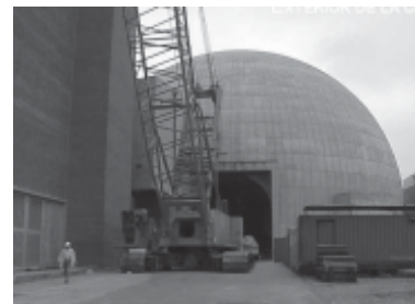
Central Nuclear Atucha II (en construcción) Entrada al edificio del reactor
