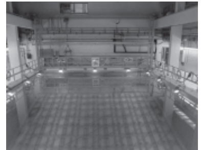
Piletas para almacenamiento temporario de elementos combustibles gastados Central Nuclear Atucha I - Pcia. de Buenos Aires
