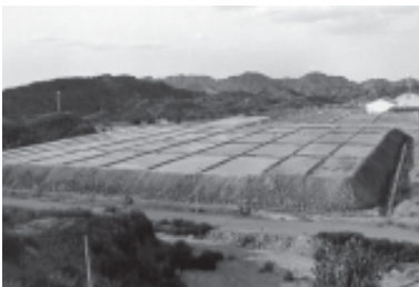
Producción de concentrado de uranio (yellow cake) Piletas de lixiviación
