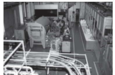
Planta de Fabricación de Elementos Combustibles para Reactores de Investigación (ECRI) Centro Atómico Constituyentes Pcia. de Buenos Aires
