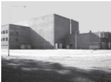
Edificio de los Laboratorios de Ensayos Pos Irradiación (LAPEP) y de Facilidades Radioquímicas (LFR) Centro Atómico Ezeiza – Pcia. de Buenos Aires
