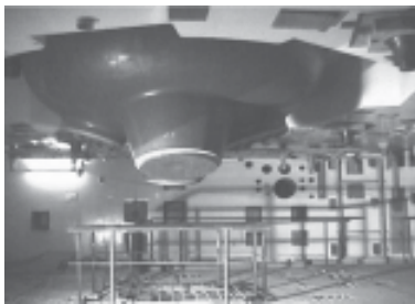
Central Nuclear Atucha II (en construcción)
