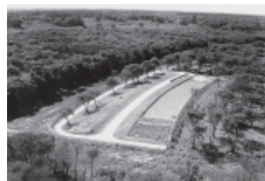
Trinchera para almacenamiento temporario de residuos de baja actividad
