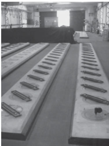
Almacenamiento temporario de combustible gastado de reactores de investigación
