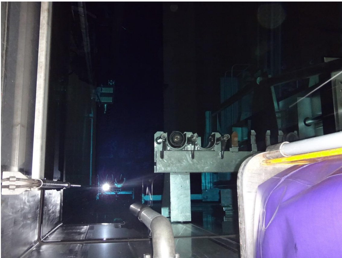
Foto 4: Foto de zona 1 en piletas de maniobras, vista lateral.
