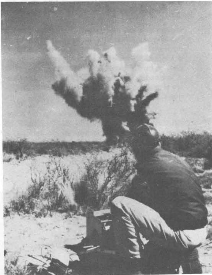
Tareas de Exploración. Operativo de prospección geofísica. Línea de sísmica en el momento del registro.
