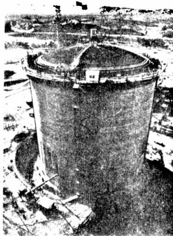
FOTO 4. HORMIGONADO DE LA PARED PERIMETRAL DEL EDIFICIO DEL REACTOR (JUNIO DE 1976).
