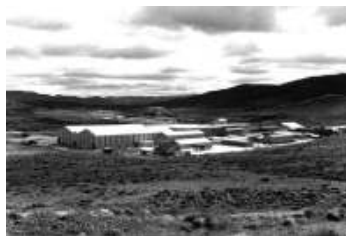
Planta de Enriquecimiento de Uranio Complejo Tecnológico Pilcaniyeu Pcia. de Río Negro
