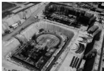
Reactor CAREM Construcción del edificio del reactor
