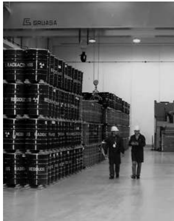
Depósito de residuos radiactivos y fuentes irradiadas en desuso Área de Gestión Ezeiza
