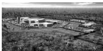
Nueva Planta de producción de Dióxido de Uranio en construcción en la Pcia. de Formosa
