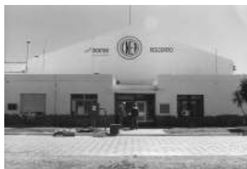
Sede de DIOXITEK S.A. Complejo Fabril Córdoba Ciudad de Córdoba
