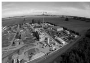
Proyecto CAREM Construcción del edificio para el reactor
