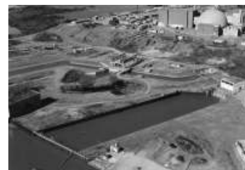
Central Nuclear Atucha II Toma de agua
