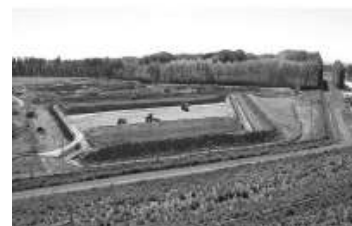
Proyecto Restitución Ambiental de la Minería del Uranio (PRAMU) Trabajos de restitución en el Ex - Complejo Minero Fabril Malargüe
