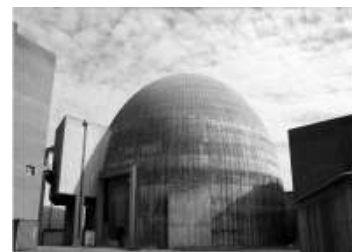
Central Nuclear Atucha II Recinto de contención
