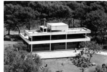
Gestión de residuos radiactivos Edificio de acondicionamiento Área de Gestión Ezeiza Pcia. de Buenos Aires
