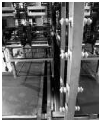
Planta de Irradiación Semi Industrial Centro Atómico Ezeiza
