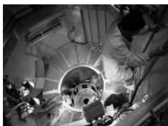
Tanque del reactor de investigación RA-8 Centro Tecnológico Pilcaniyeu
