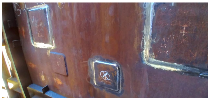
(a) Soldaduras sobre el Módulo 10
