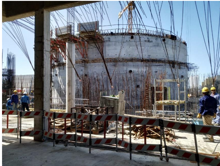
Figura 1: obra civil del CAREM25.
