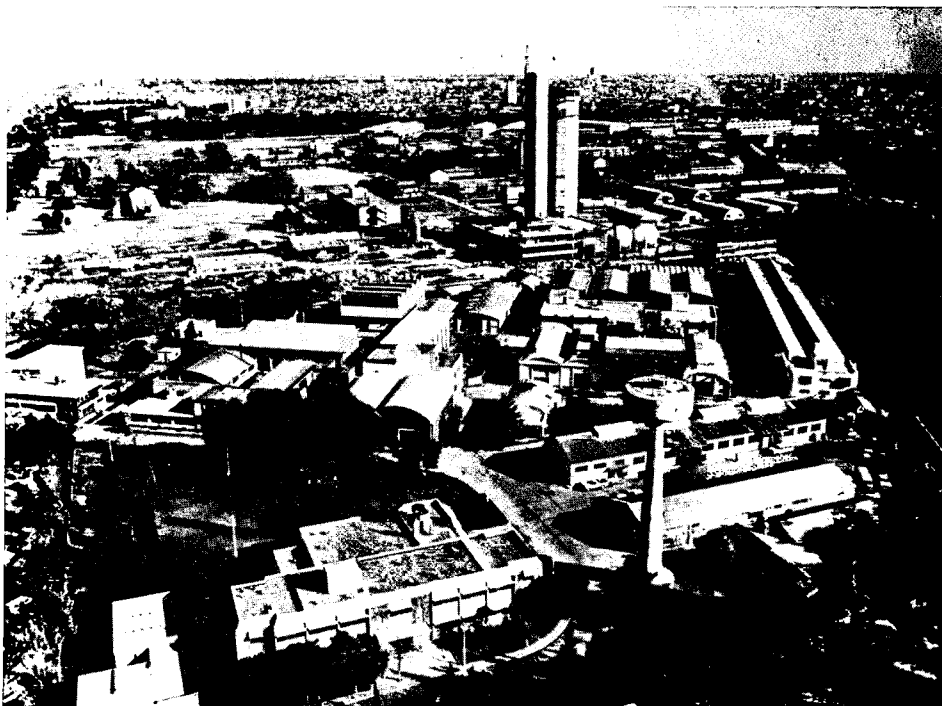
Centro Atómico Constituyentes, sobre la intersección de las avenidas General Paz y de los Constituyentes. Inmediatamente detrás, en construcción, la torre que albergará al acelerador. Los tanques esféricos, adelante y hacia la derecha de la torre, son los tanques de almacenamiento del exafluoruro de azufre.
