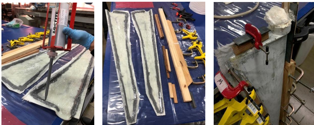
Figura 3.16 – Colocación de adhesivo e inyección núcleo de espuma PU.
