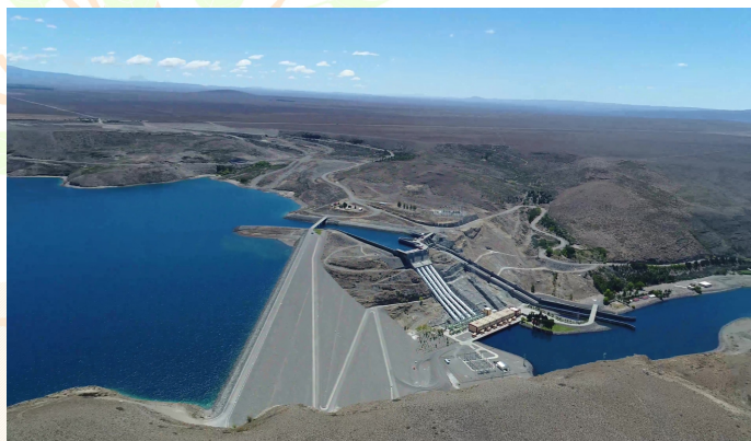
Represa de Alicurá es el primer dique sobre el río Limay, al N.O. de la región del Comahue, entre las provincias Neuquén y Río Negro. Es de 1050 MW de potencia. En medio de la foto se aprecian las cuatro tuberías que llevan agua a presión desde el embalse hasta las turbinas. (Gentileza: www.argentina.gob.ar )
