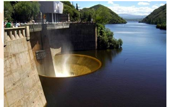
Dique San Roque es una represa ubicada en el departamento Punilla, provincia de Córdoba. Es de 34 MW de potencia y posee vertedero tipo tulipa.
