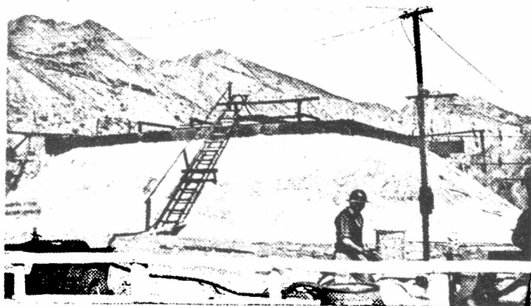
Pila experimental de preconcentración mediante lixiviación por capilaridad.
