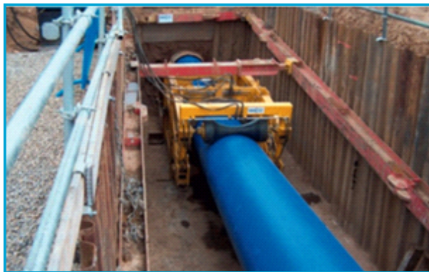
Figura 7. Revestimiento de polietileno de alta densidad que se coloca en la tubería.
