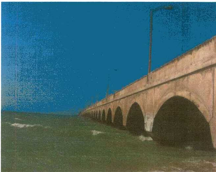
Figura 2.6. Muelle fiscal de Progreso Castro, península del Yucatán. Primer registro de obra construida con refuerzos de acero inoxidable (1941) [26].
