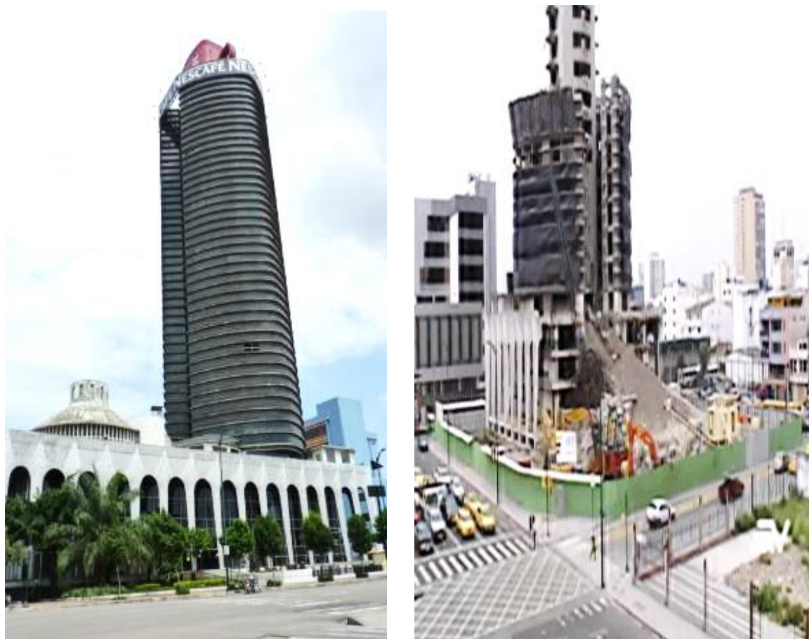
Figura 1.4. Edificio Ministerio de Agricultura "MAGAP" durante su proceso de demolición en el año 2014. Fuente: Autor.
