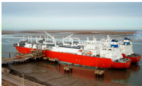
Terminal de GNL de la compañía Mega S.A. en Bahía Blanca, provincia de Buenos Aires. 9
