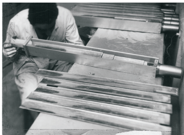
Fabricación de elementos combustibles para el reactor de investigación RA-3
