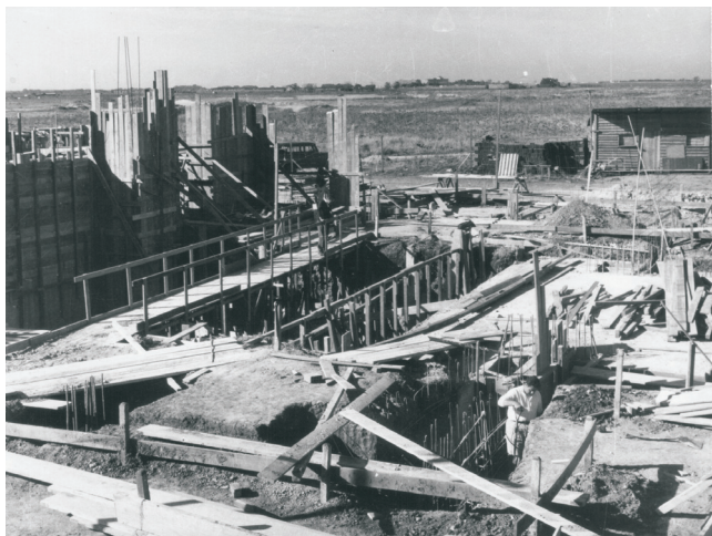
Inicio de la construcción del RA-3
