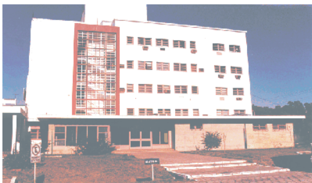
Edificio del Reactor RA-3
