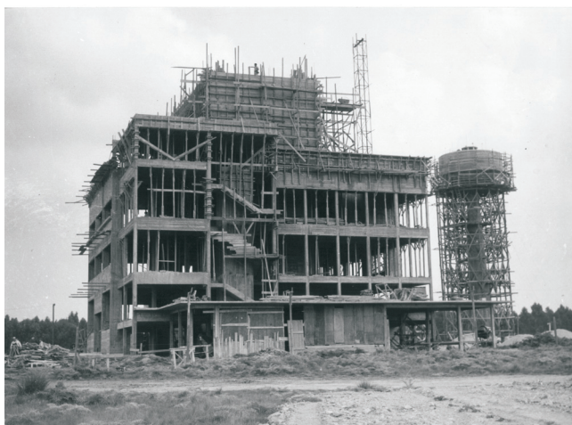
Construcción del edificio del reactor
