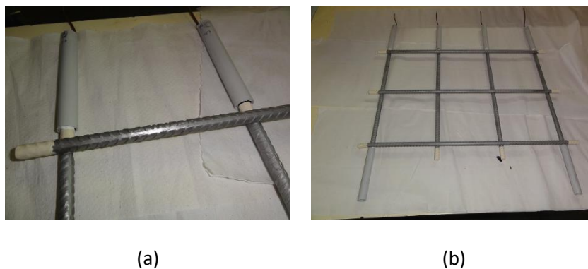
Figura 3.30. (a) Preparación de las mallas electrosoldadas. (b) Protección, aislamiento de contactos y extensión de la malla con tubos de PVC para fijación en molde.
