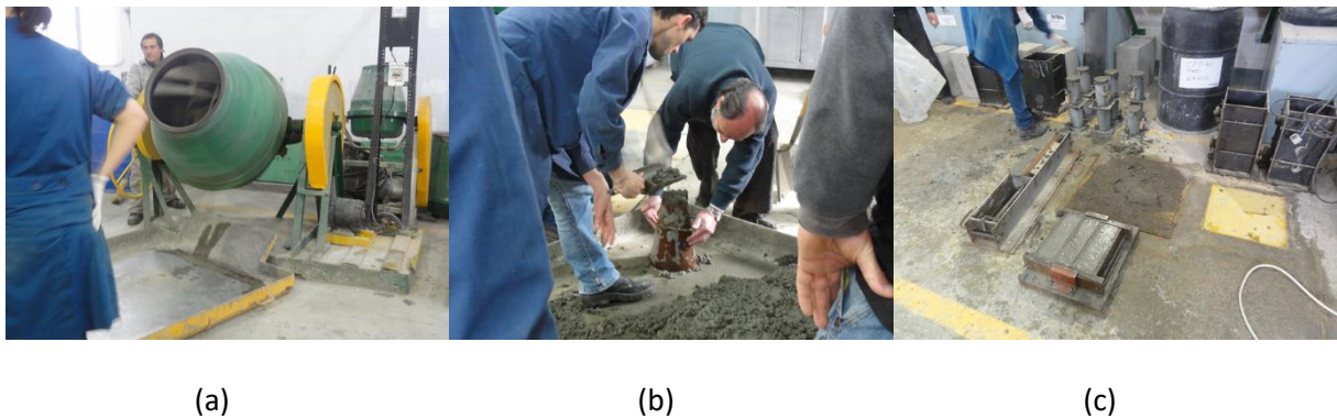
Figura 3.38. (a) Mezclado de componentes del hormigón. (b) Ensayo del cono de Abrams. (c) Llenado de probetas para ensayos de carbonatación y de difusión de cloruro.
