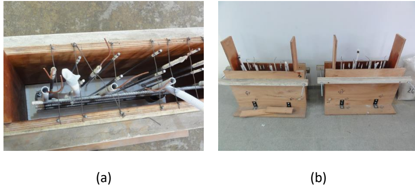
Figura 3.37. Molde armado. (a) Elementos metálicos que quedarán embebidos, mostrando a todos los elementos unidos con alambres a las paredes del molde en su parte superior. (b) Vista general de dos moldes armados en espera del hormigonado.
