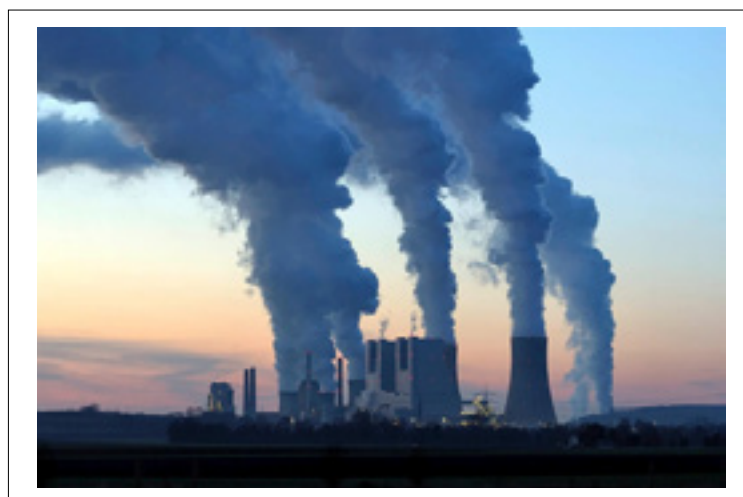
Figura 4: Centrales termoeléctricas de carbón Neurath I y Neurath II, Alemania.
