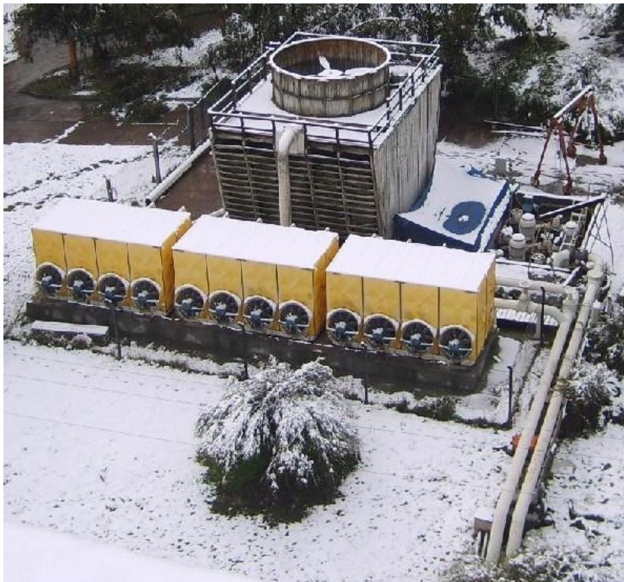
Figura nº 5: Circuito Secundario de Refrigeración
