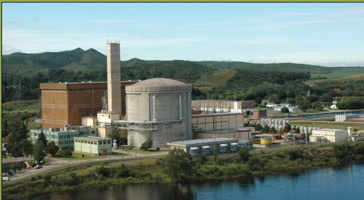
Figura 4: Vista aérea de los silos de la Central Nuclear Embalse.
