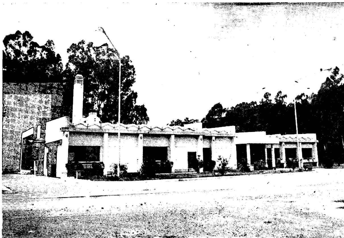
BIOTERIO: Vista exterior de la planta
