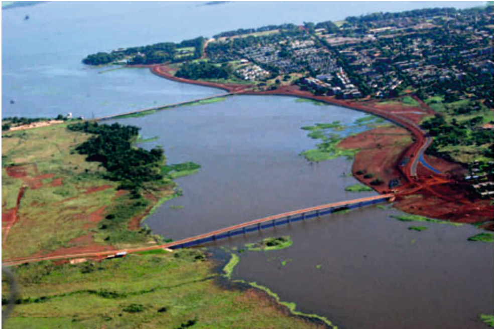
Figura 8: Obras en la región costera de Posadas, Misiones
