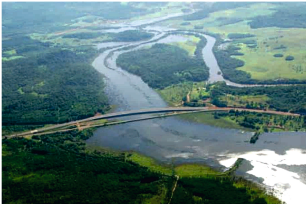
Figura 7: Puente sobre el río Yabebiry
