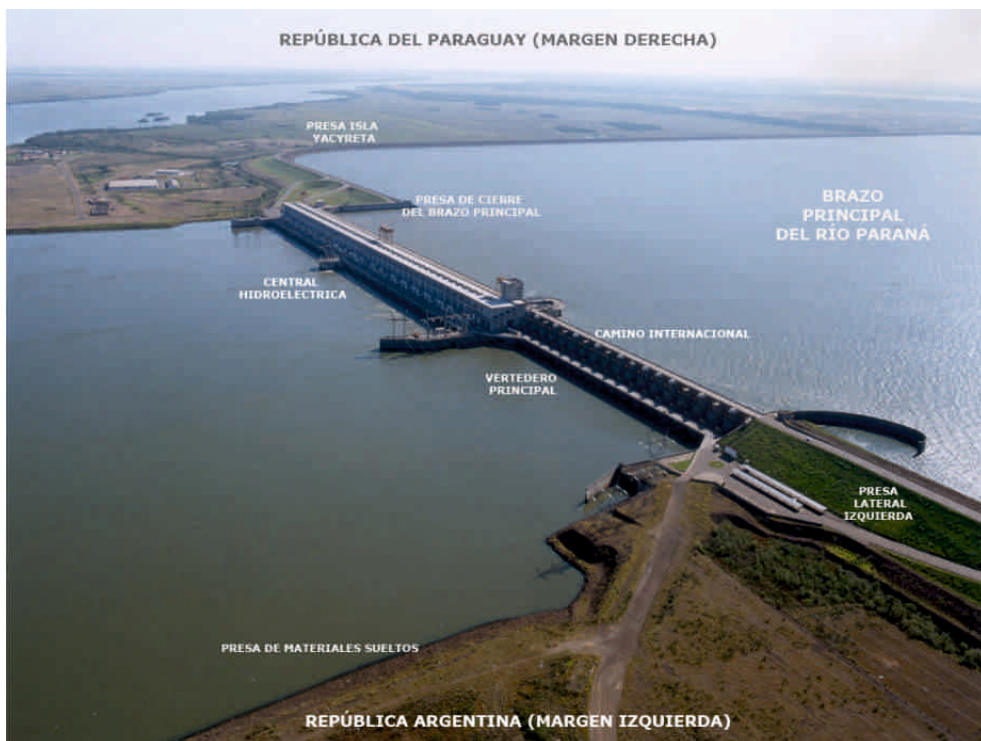
Figura 2: Central hidroeléctrica Yacyretá
