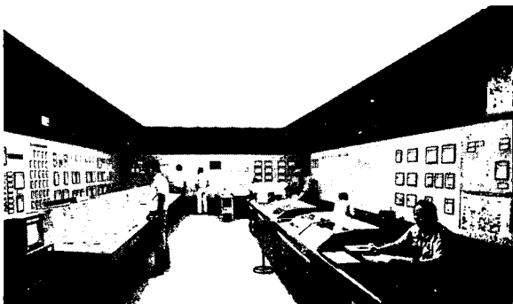
F. 11 Central Nuclear Atucha. Sala de control.
