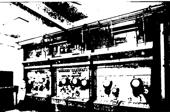
F. 25 Planta de producción de radioisótopos y sustancias marcadas. Vista parcial (Centro Atómico Ezeiza).
