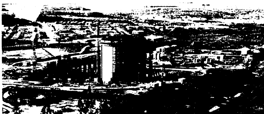
F. 13 Central Nuclear en Embalse, Provincia de Cordova. Estado de la construcción a comienzos de 1977.
