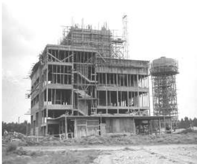
Reactor RA-3 en construcción en el Centro Atómico Ezeiza (circa 1966)
