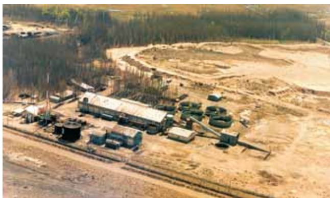
Vista general de las instalaciones
