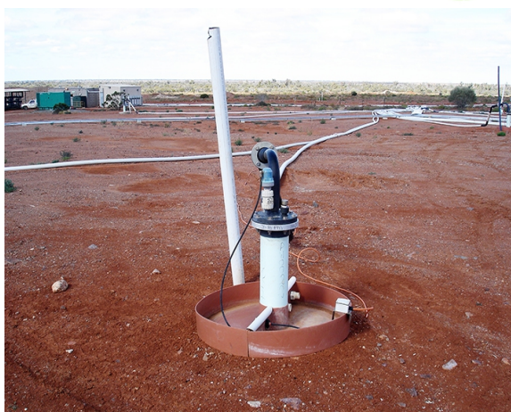
Método lixiviación in situ - Depósito de uranio Beverley (Australia) - Heatgate Resources Ltd.
