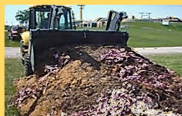
Movimiento de tierra
